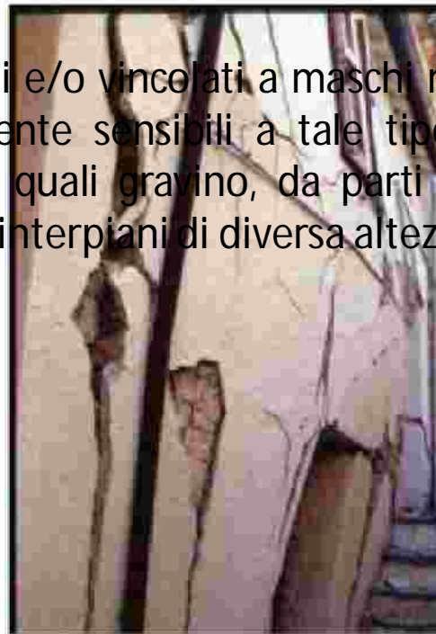
Fig. 1.2 – Meccanismi di flessione verticale (Foto da: MEDEA - Zuccaro, Papa - 2003, DPC)
